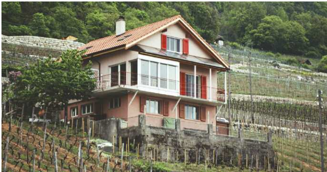
Solaranlage an Fassade
